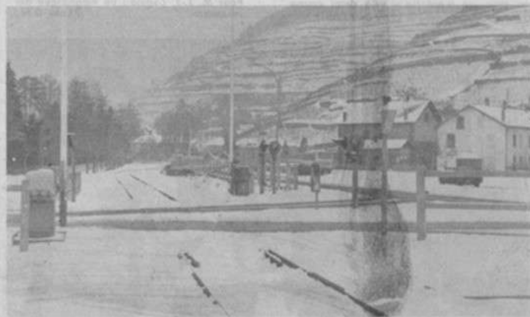
L'ancien emplacement de la gare de marchandises du Quaterfeld, aujourd'hui traversé par la pénétrante. (Photos DN)
