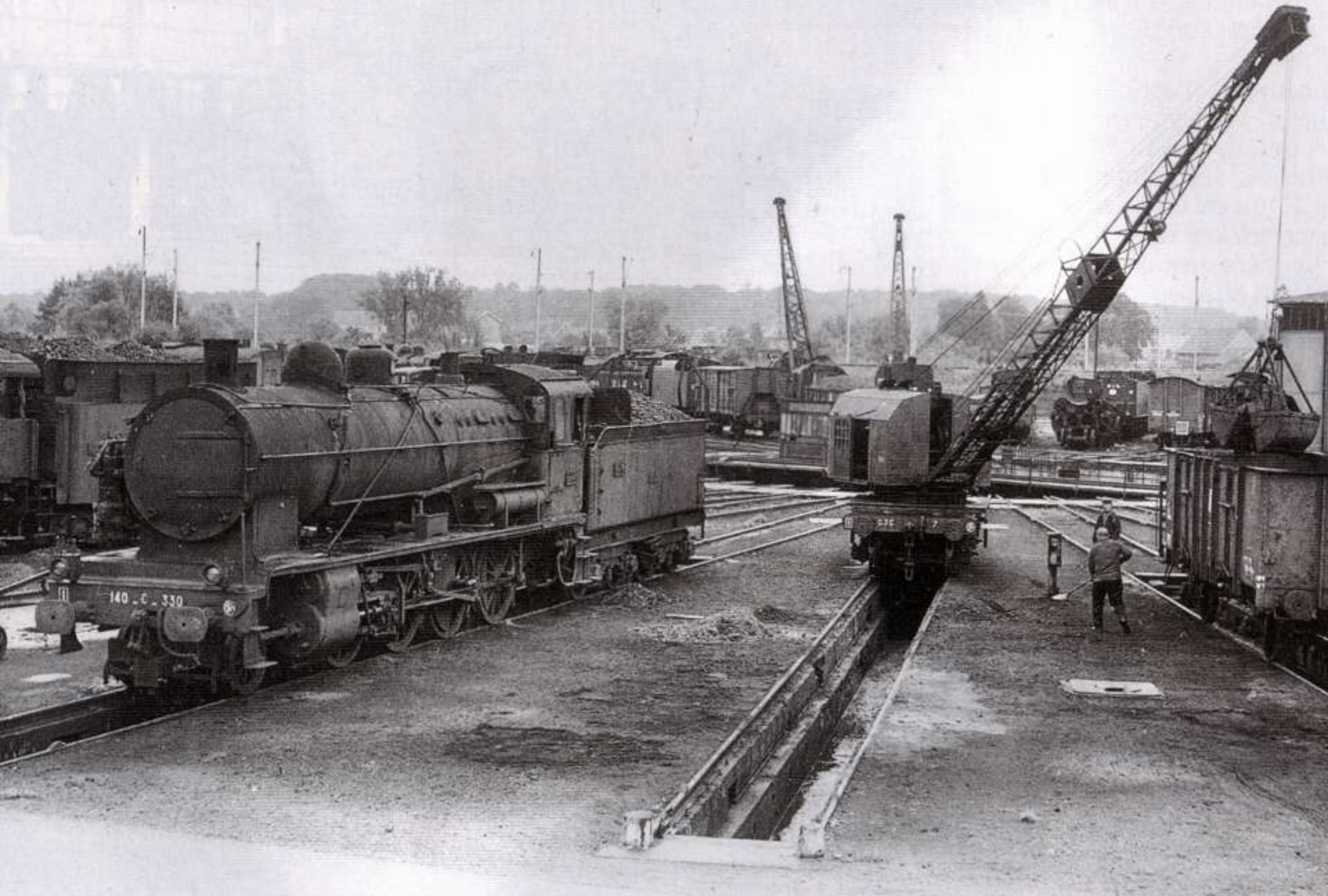
Le dépôt de locomotives de Belfort
