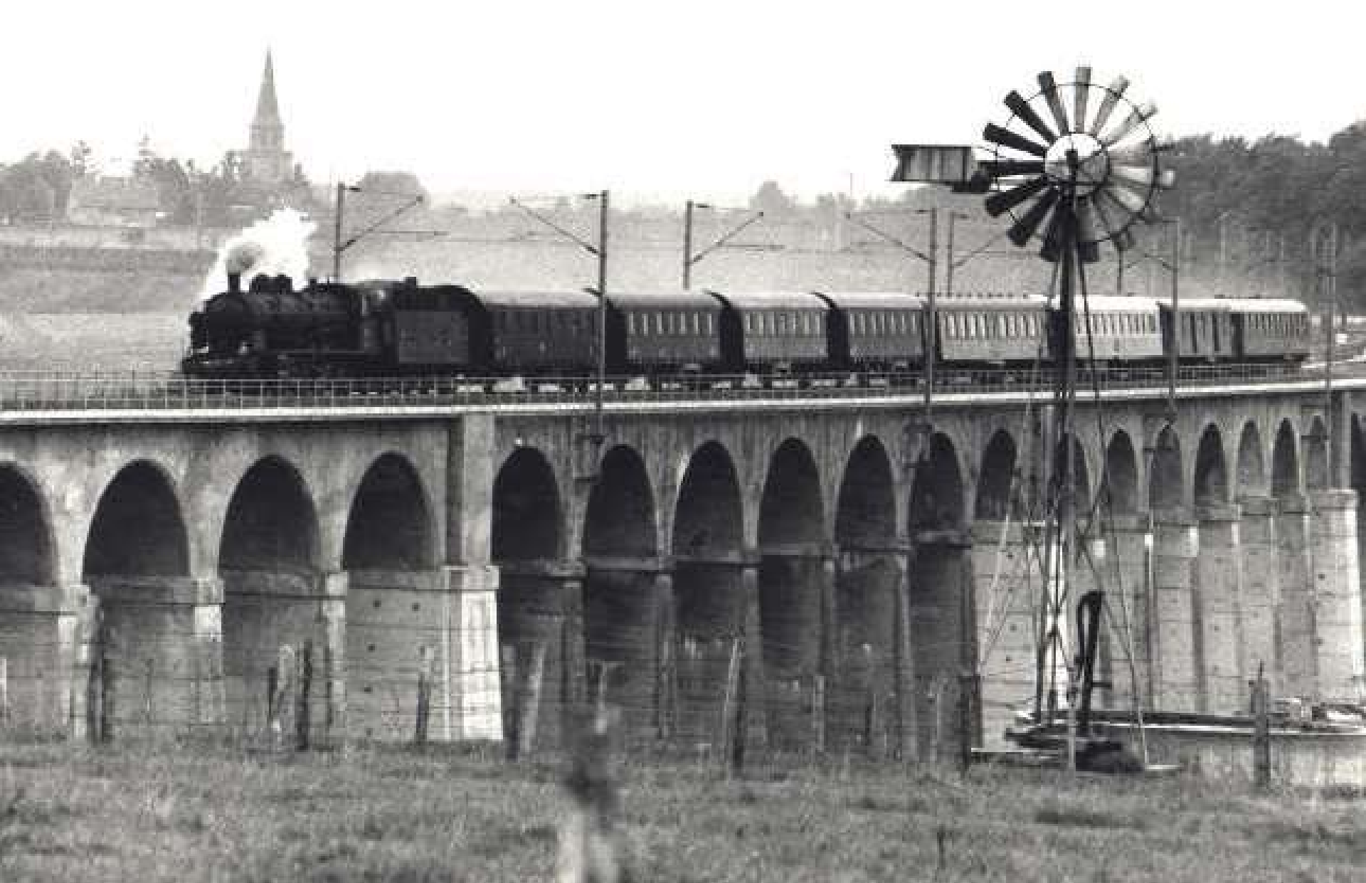
Un train Belfort – Mulhouse sur le viaduc de Dannemarie
