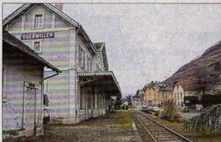
L'ancienne gare de Guebwiller est occupée actuellement par l'association Défi.
