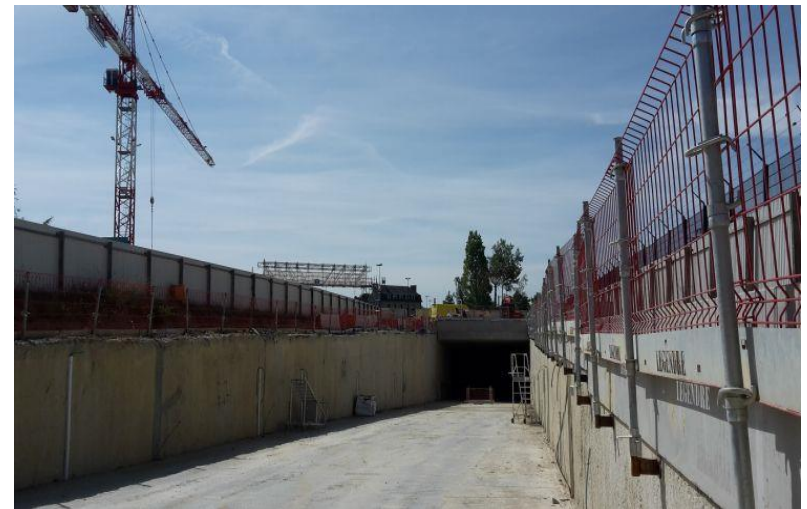
Exemple de tranchée couverte
