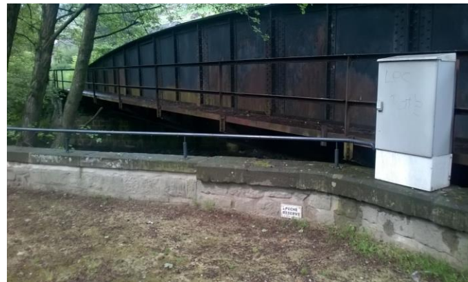
Vue rapprochée de la poutre latérale
