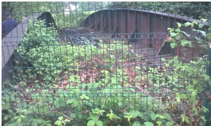
Vue intérieure de l'ouvrage (plancher)
