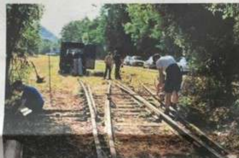
A droite, la machine permettant de dévisser les tire-fonds.
