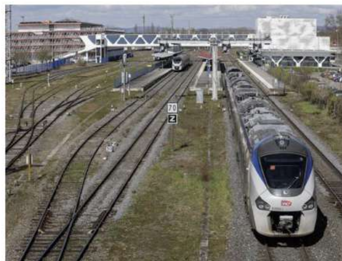
Un budget d'un million d'euros est prévu pour des études préparatoires concernant le projet d'électrification de la ligne Strasbourg-Haguenau. Photo Jean-François Badias
