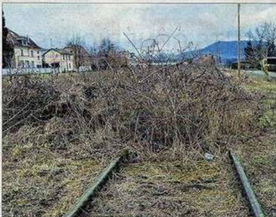
La ligne Bollwiller-Guebwiller à Soultz.
