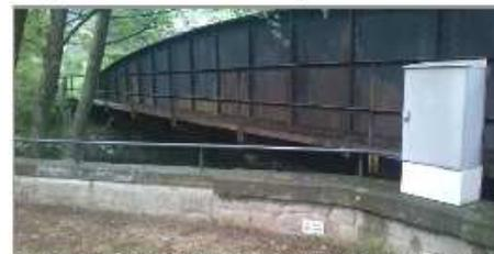
**Le pont sur la Lauch** à Guebwiller sera réutilisé. Il est assez bien conservé. Seul le plancher devra être remplacé. La protection anticorrosion pourra être réalisée ultérieurement.
